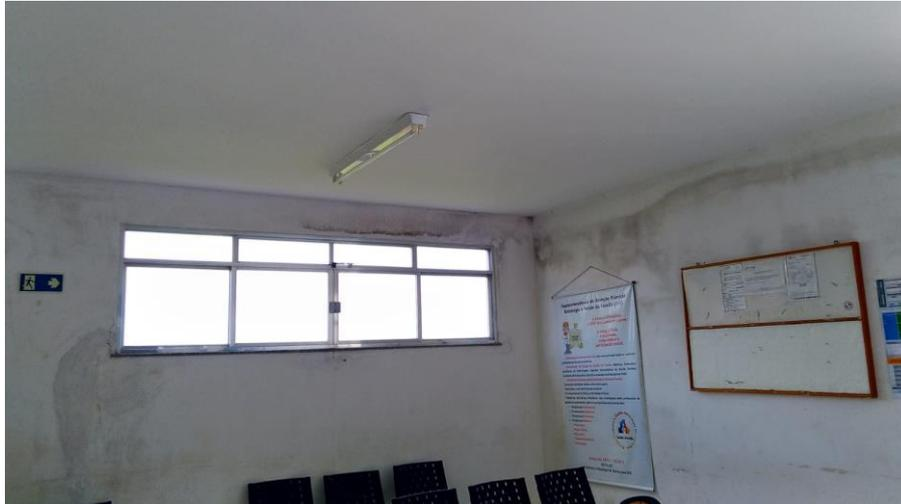
Figura 10 – Infiltrações nas paredes internas
