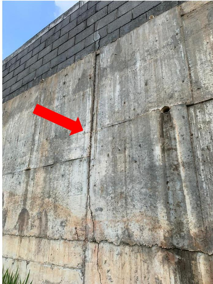
Figura 25 - Trinca muro lateral
