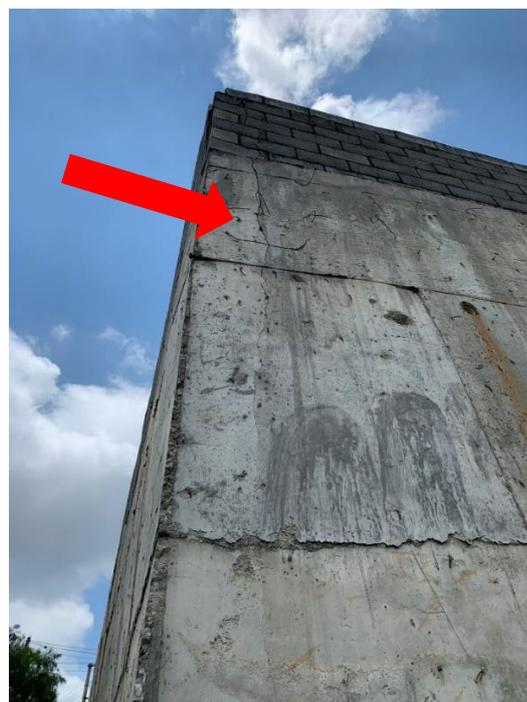
Figura 24 - Trinca (2) muro dos fundos
