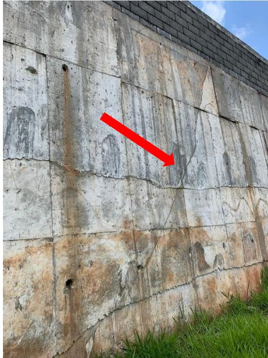
Figura 23 - Trinca muro (1) dos fundos
