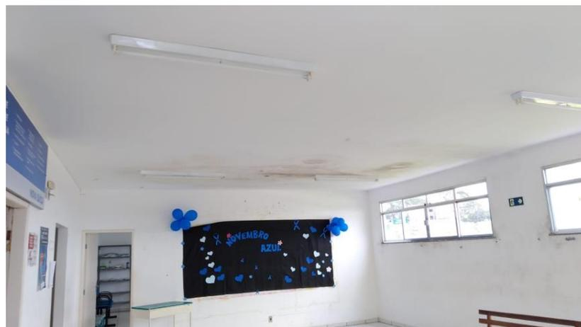
Figura 2 - Infiltrações devido ao problema do telhado
